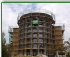
Fassadengerüstbau
